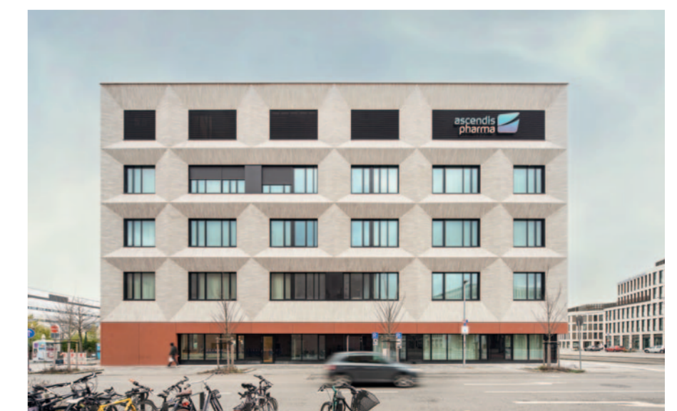
Perfektes Zusammenspiel zwischen Klinkerfassade und Sockelgeschoss
