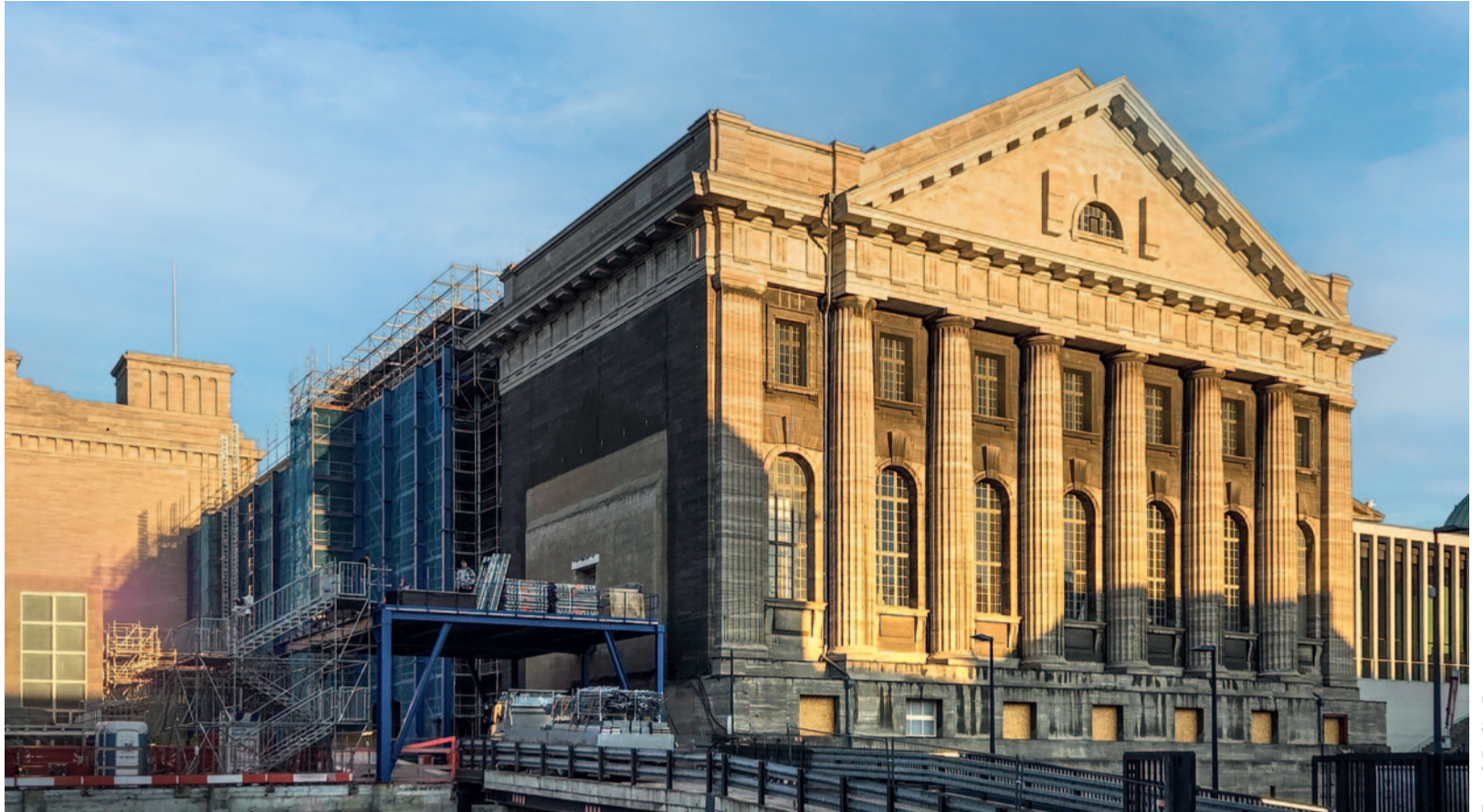
Foto: © Dreßler Bau
