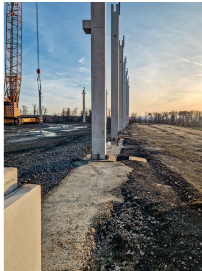
Die Bauarbeiten schreiten zügig voran
