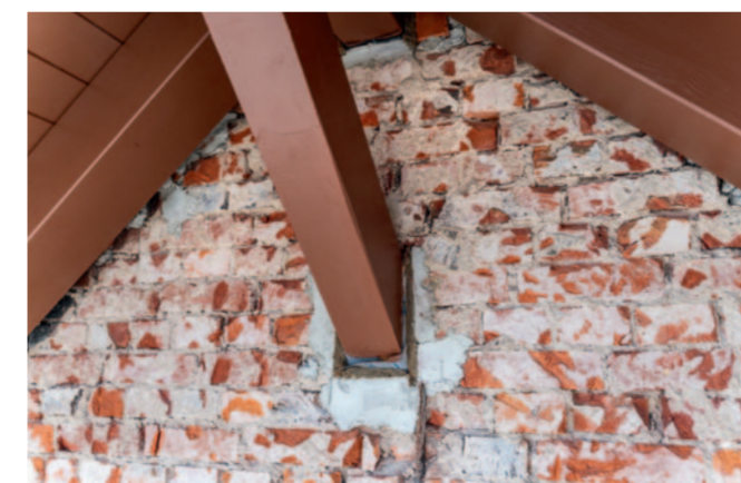
As it was: der historische Dachstuhl
