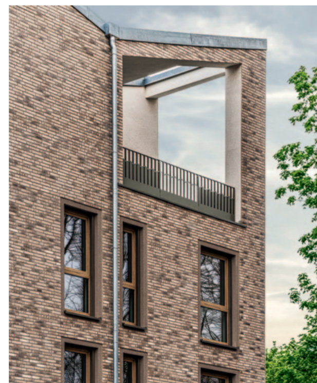
Außergewöhnliches Raumgefühl: in das Schrägdach integrierte Loggia
